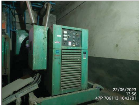
ภาพที่ 6 เครื่องสำรองไฟฟ้าสำหรับจ่ายไฟฟ้าให้ระบบบำบัดมลพิษทางอากาศ
