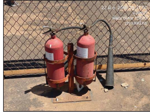
ภาพที่ 45 (ต่อ) การติดตั้งอุปกรณ์ดับเพลิง
