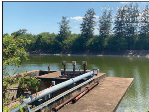
ภาพที่ 24 บ่อดักตะกอนชนิดบ่อกอนกรีต ขนาด 900 ลูกบาศก์เมตร
